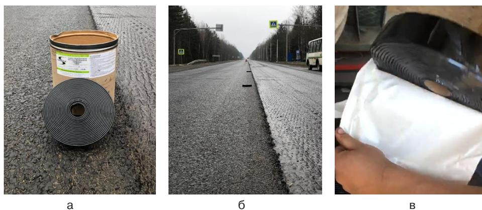
**Рис. 3.** Картонный барабан с информацией о ленте (а), раскладка рулонов ленты вдоль образуемого шва сопряжения (б), антиадгезионный прокладочный слой для предотвращения слипания рулонов ленты при транспортировке и хранении (в)
